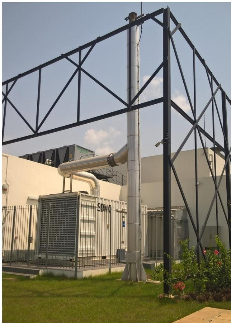
*Illus.3 : Vue de l'un des deux groupes électrogènes de 1400 kVA installé à proximité du data center.*
