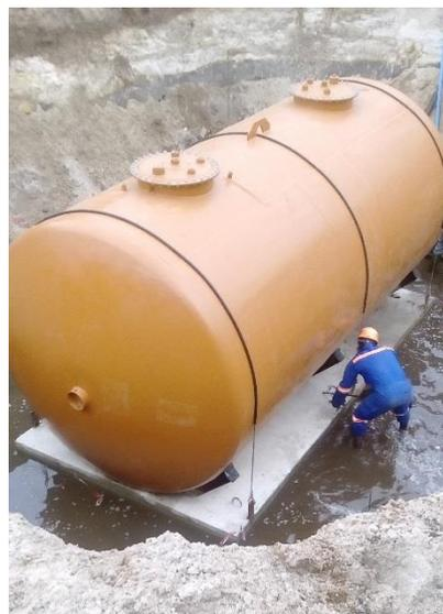
*Illus.2 : L'une des deux cuves de 25 000 litres en cours de pose sur le site*
