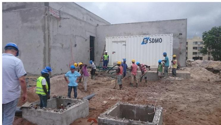
*Illus.1 : Installation en cours des deux groupes électrogènes de 1400 kVA sur le site*
