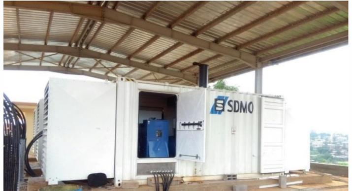
*Ilustr. 2. Tres grupos electrógenos cada uno instalados en tres contenedores Super Silent.*
