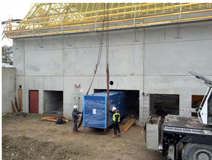
*Illus. 2 : Installation du groupe électrogène de 550 kVA dans le local de 27m<sup>2</sup> prévu à cet effet*
