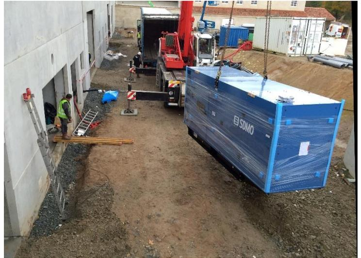
*Ilustr. 1: El grupo electrógeno de 550 kVA encaminado a su posición por los equipos de mantenimiento.*
