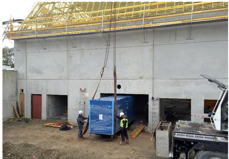
*Ilustr. 2: Instalación del grupo electrógeno de 550 kVA en el local de 27 m<sup>2</sup> previsto al efecto*
