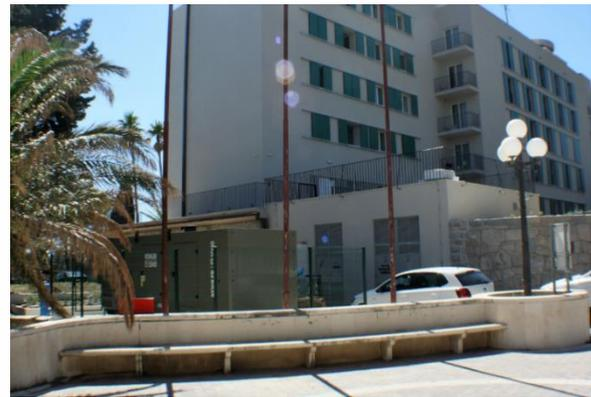
*Ilust. 1: El grupo electrógeno KD1100 en versión carenada instalado junto al hotel*
